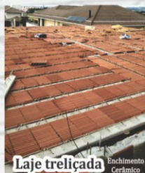
Laje treliçada Enchimento Cerâmico
